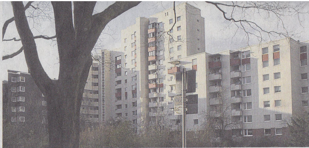
Das Stadtbild in Seeberg-Nord ist geprägt von Hochhäusern.
